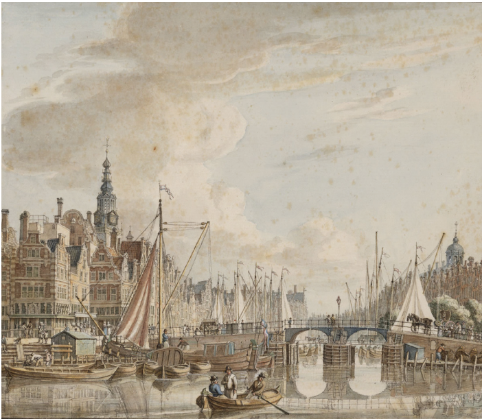
Figuur 1. De Nieuwe Brug aan het begin van het Damrak.
